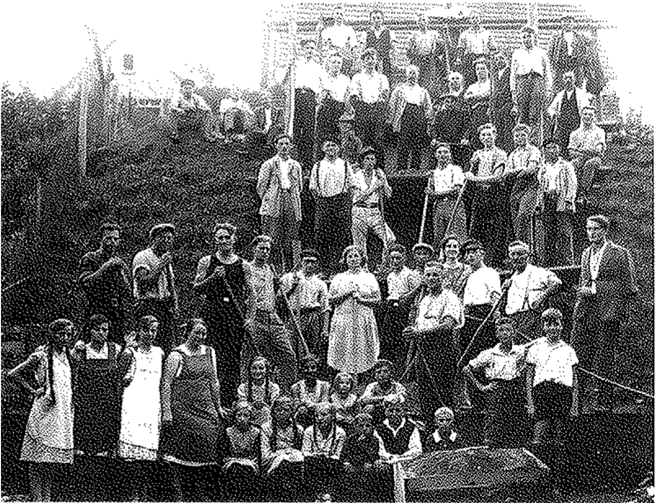
Baubeginn 1922 an der Turnhalle des Arbeiter-Sportkartells in der Stiftstrasse 56
